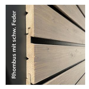
Die schwarze Feder hebt die geschlossene Fassade als offene Holzfassade hervor.
